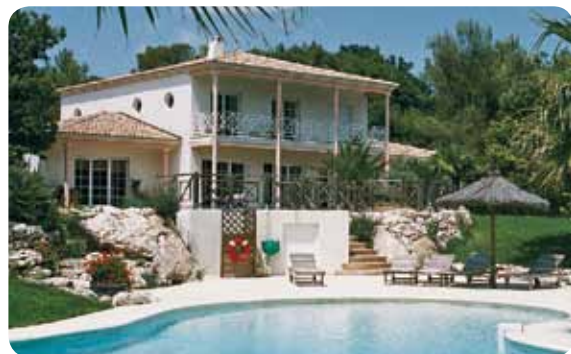
Posiadłość 308 m 2 w systemie Natea Sofath 4 kompresory, wymiennik gruntowy 490 m 2 Opcje: klimatyzacja, c.w.u., ogrzewanie basenu
